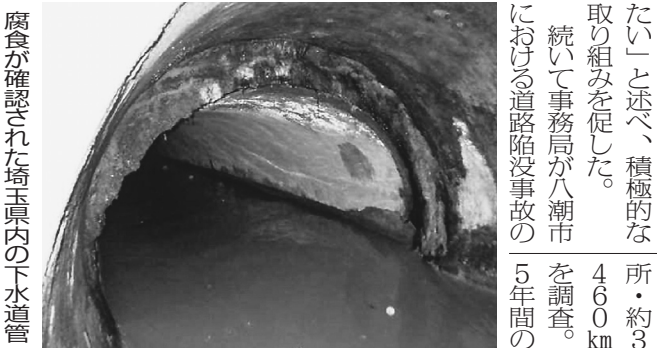
腐食が確認された埼玉県内の下水道管
