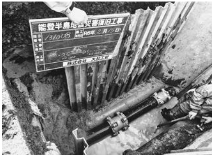
水道管の漏水を修繕(株大起工管提供)
