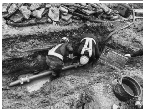
志賀町で漏水修理を行う神奈川協組
