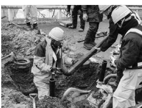
能登町でパイプを交換する橋本市協組
