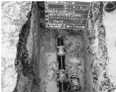
輪島市洲衛地区の漏水修理
