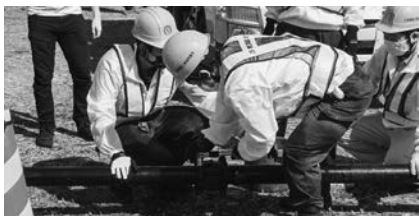
亀裂部分に特殊継手を取り付けて止水
