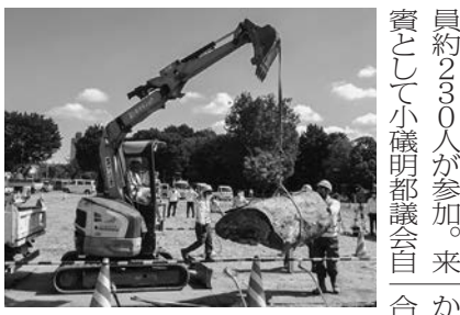
今回初の道路啓開訓練
