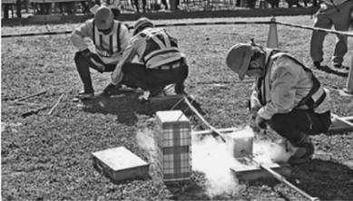
凍結工法で漏水箇所を修理
