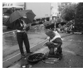
風雨の中で点検作業
