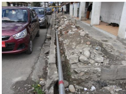
パロの中心部で見た水道管布設風景
