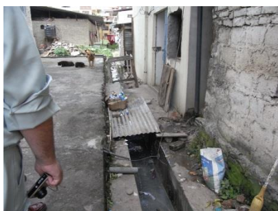
国際空港があるパロの裏通り。生活雑排水は垂れ流し、し尿は腐敗槽処理のみ
