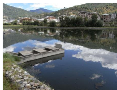
首都ティンプーのラグーン式処理場。周辺は住宅の開発が進んでいる
